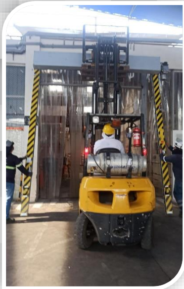
Instalación de equipos industriales
